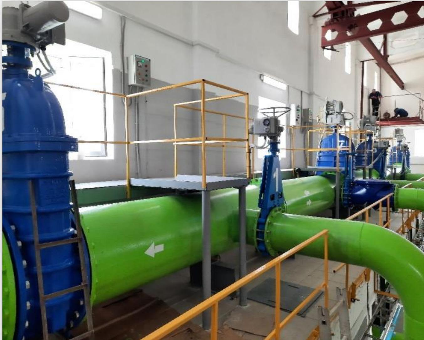
ПРОИЗВЕДЕНА ЗАМЕНА 4-Х НАПОРНЫХ ШИБЕРНЫХ ЗАДВИЖЕК ДУ-400, 2-Х ШАРОВЫХ ОБРАТНЫХ КЛАПАНА, 1-ГО ДИСКОВОГО КЛАПАНА ГОРИЗОНТАЛЬНОГО ИСПОЛНЕНИЯ
